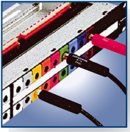
Patchkabel und Farbmarkierungen
